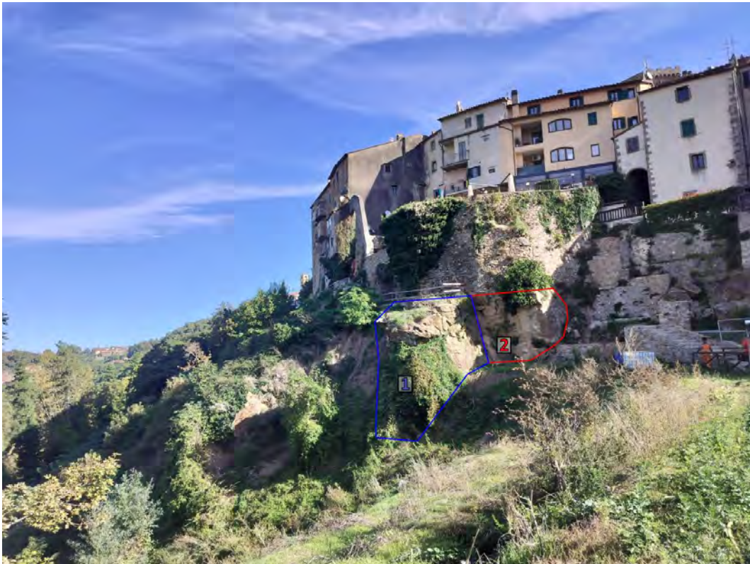
Fig.11: documentazione fotografica con indicazione delle aree d'intervento principali: ammasso roccioso di Pietraforte da consolidare (1) e area di realizzazione del muro di controscarpa a sostegno dell'affioramento strapiombante (2)
