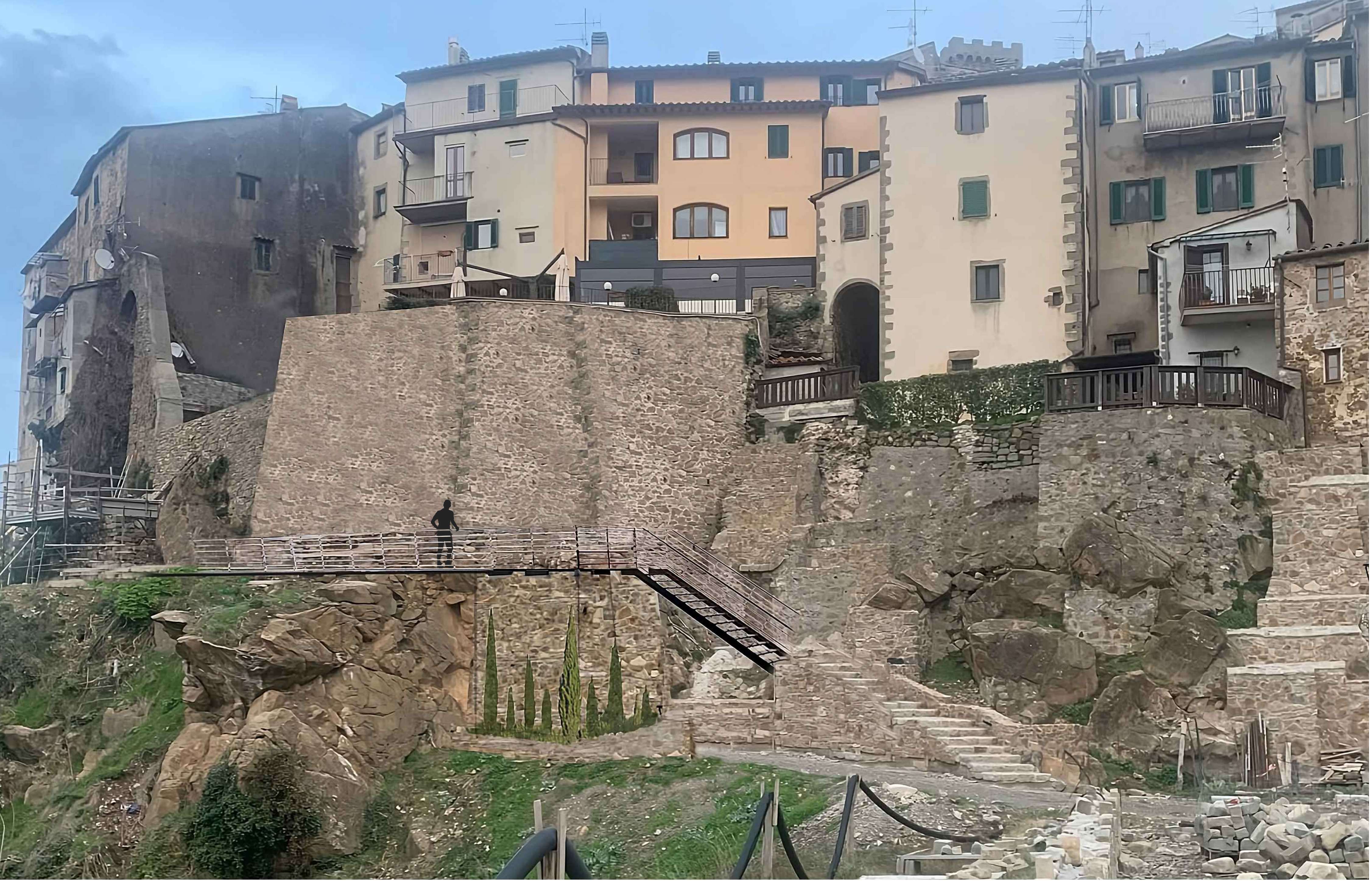
Render di progetto: particolare scala metallica, passerella e consolidamento muro
