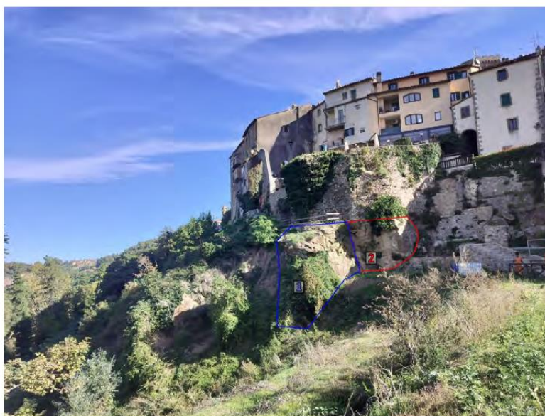
Fig. 24 Foto tratta dalla Relazione geologica dott. Nenci (Ott. 2025) ove sono indicate le aree d'intervento principali: ammasso roccioso di Pietraforte da consolidare (1) e area di realizzazione del muro di controscarpa a sostegno dell'affioramento strapiombante (2)
