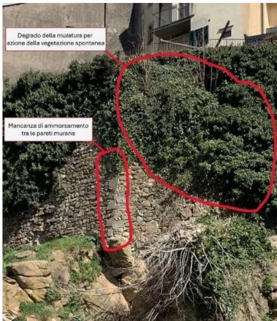
Fig. 68 Zona 4 -Rilievo fotografico intervento di integrazione del tessuto murario (scuci e cucì)
