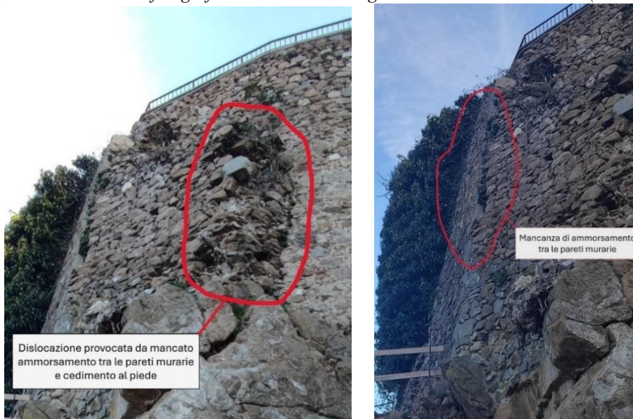
Fig. 68 Zona 4 -Rilievo fotografico intervento di integrazione del tessuto murario (scuci e cucì)
