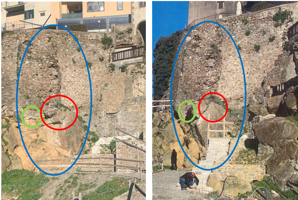
Fig 46 - 47 Veduta murazione in pietra : particolare massi fratturati
