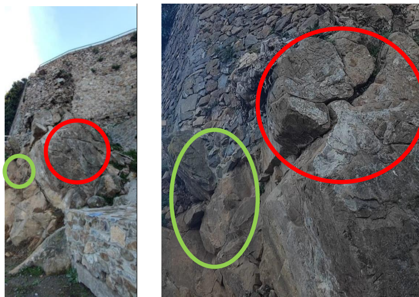
Fig 48 -49 Veduta massi fratturati Zona 4 e 5: particolare conci pericolanti
