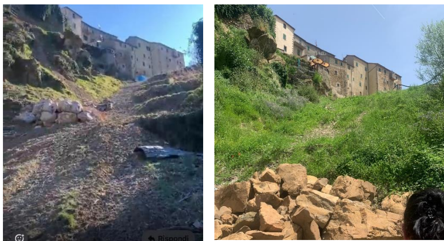
Fig. 21 e 22 Rampa di cantiere da ripristinare per transito macchina per pali presso la Zona 5
