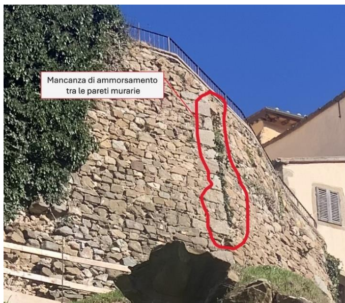
Fig.71 Zona 4 Rilievo fotografico sottostante il ristorante – Quadro lesionativo particolare distacco tra le pareti murarie
