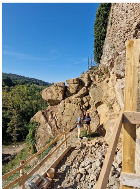
Fig. 32 Veduta laterale del fronte roccioso fratturato dopo gli interventi di messa in luce del 2024
