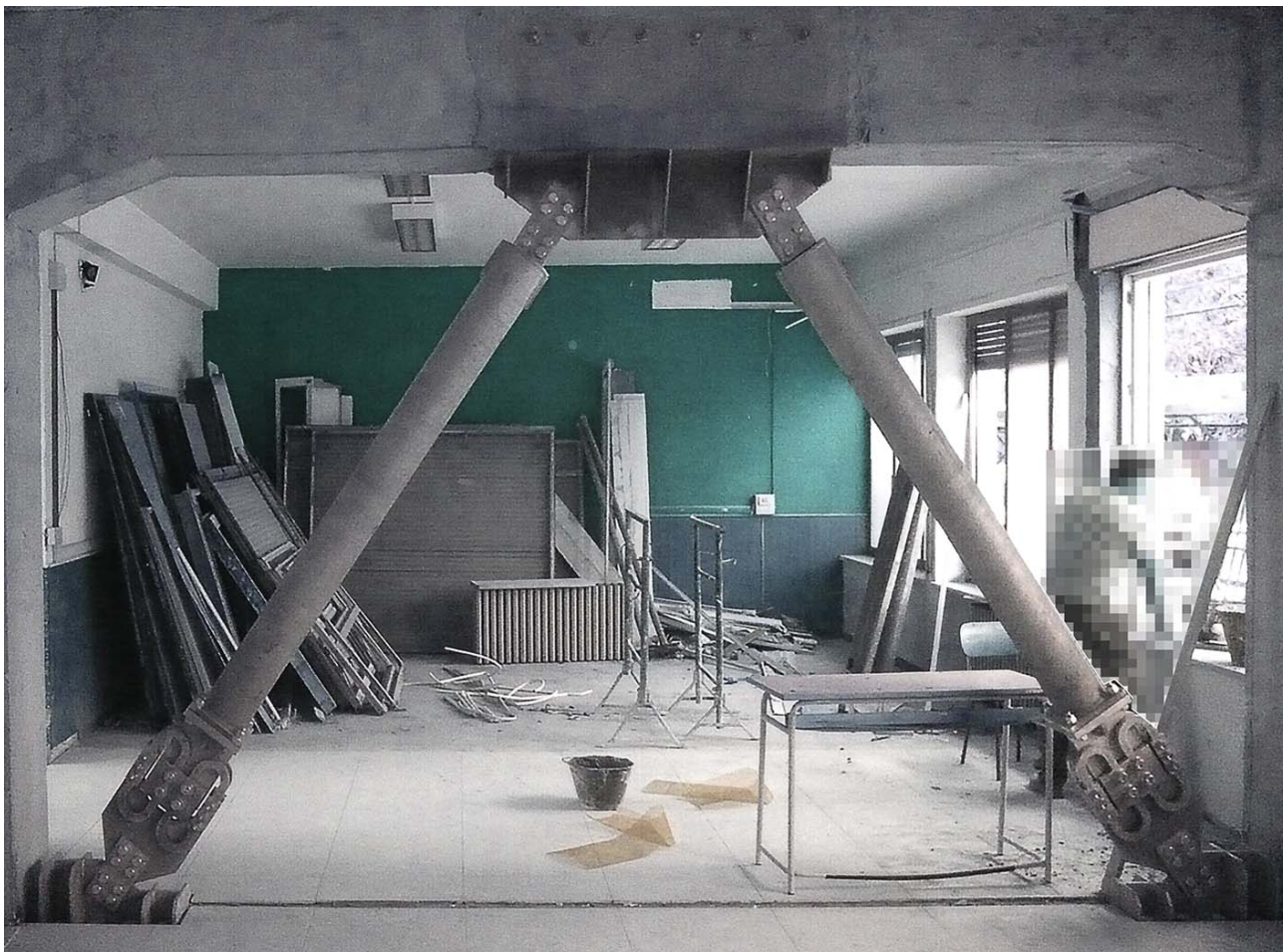
Installazione di controventi dissipativi
